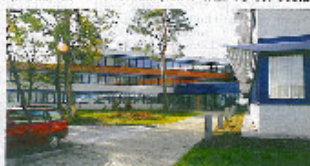
Stavba nové budovy městského úřadu v Plzeňské ulici v Plzni, která byla vybrána jako nejlepší stavba v Plzeňském kraji v roce 2008.
